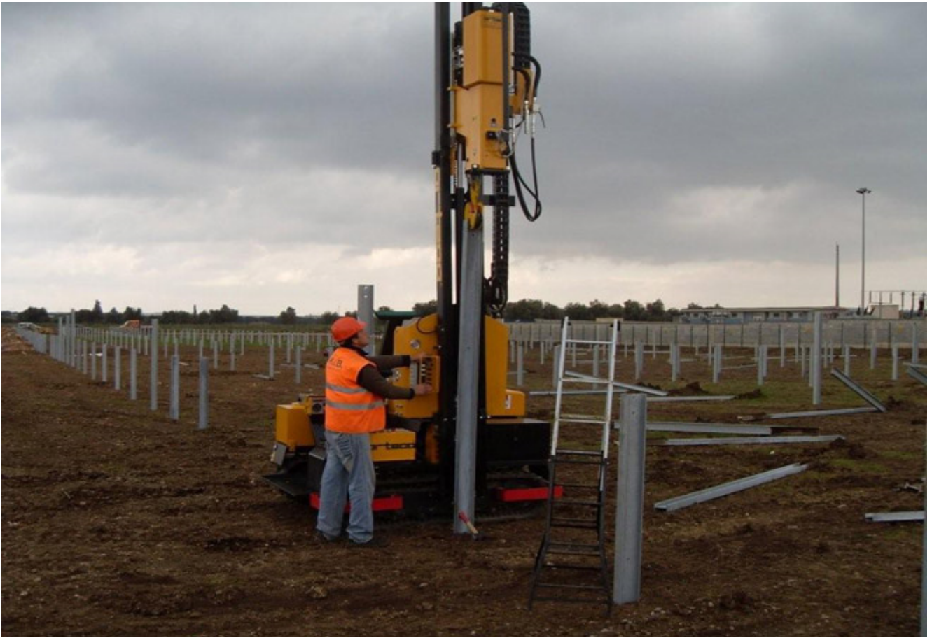
Figura 1 - Rimozione palo con macchina operatrice
