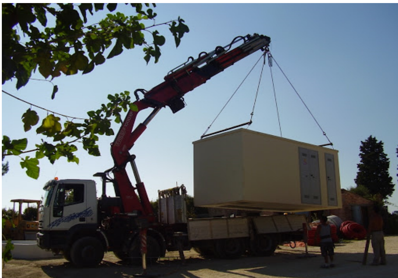
Figura 2 - Smontaggio e rimozione cabine di campo
