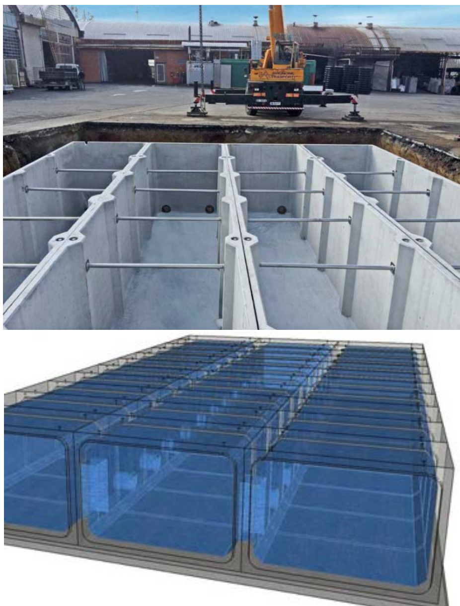
Figura 12 - Esempio di installazione di vasche monoblocco modulari
