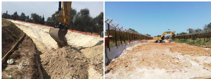
Figura 10: Rinterro della trincea con lo stesso materiale proveniente dallo scavo della trincea
