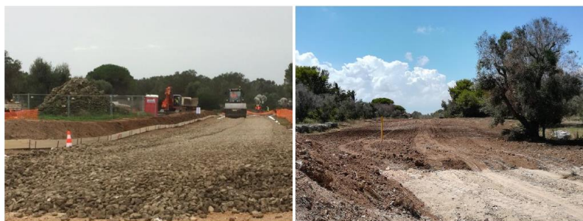
Figura 2: Realizzazione strada di accesso e Ricollocamento del Top-Soil
