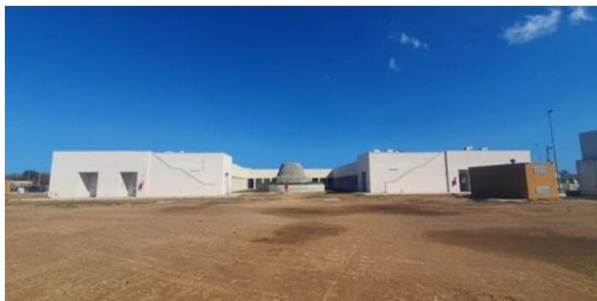
Figura 8: ricollocamento Top-Soil nel cantiere del PRT
