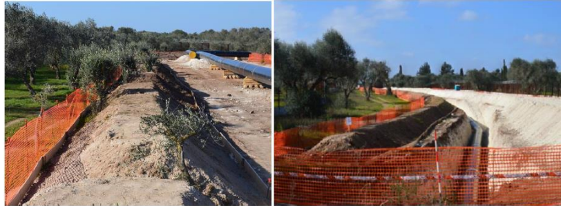
Figura 9: Separazione Top Soil e terreno profondo
