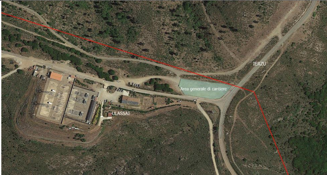
Fig. 1 – Area generale di cantiere, nei pressi della Sottostazione Elettrica.
