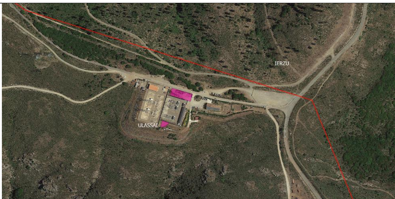
Fig. 1 – Area di ampliamento della Sottostazione Elettrica.
