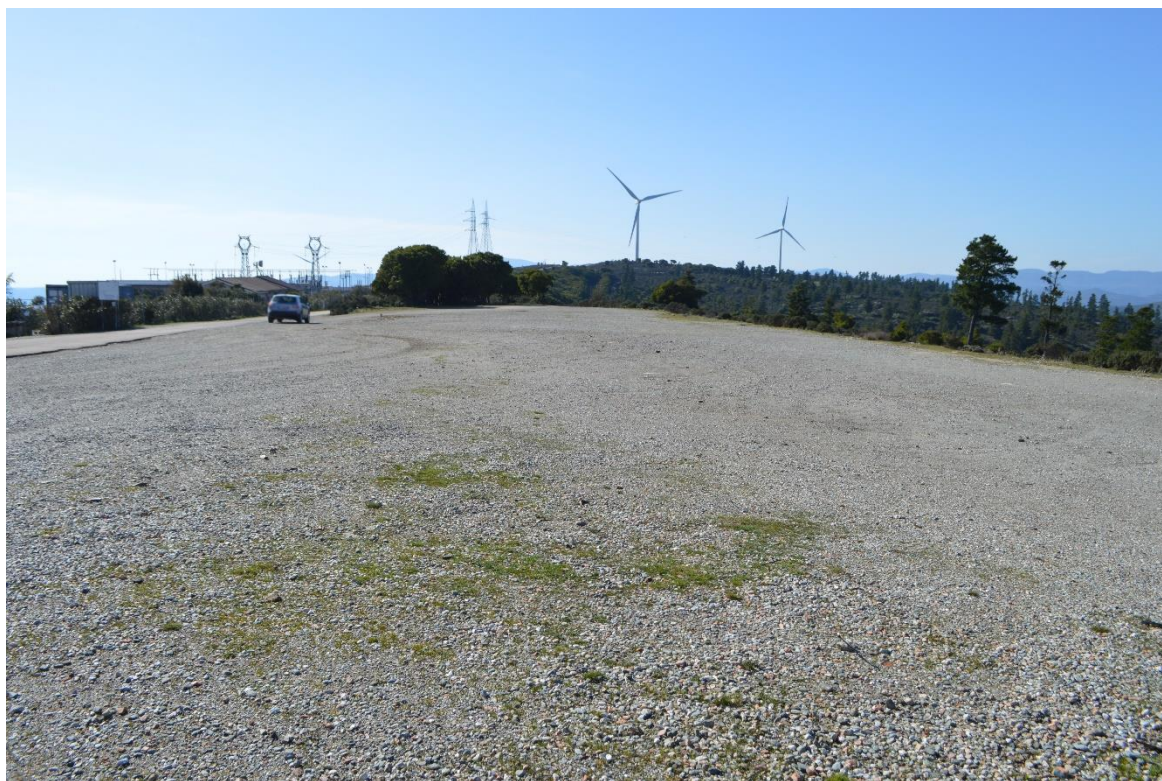
Figura 1 - Area di cantiere localizzata nei pressi della SSE esistente
