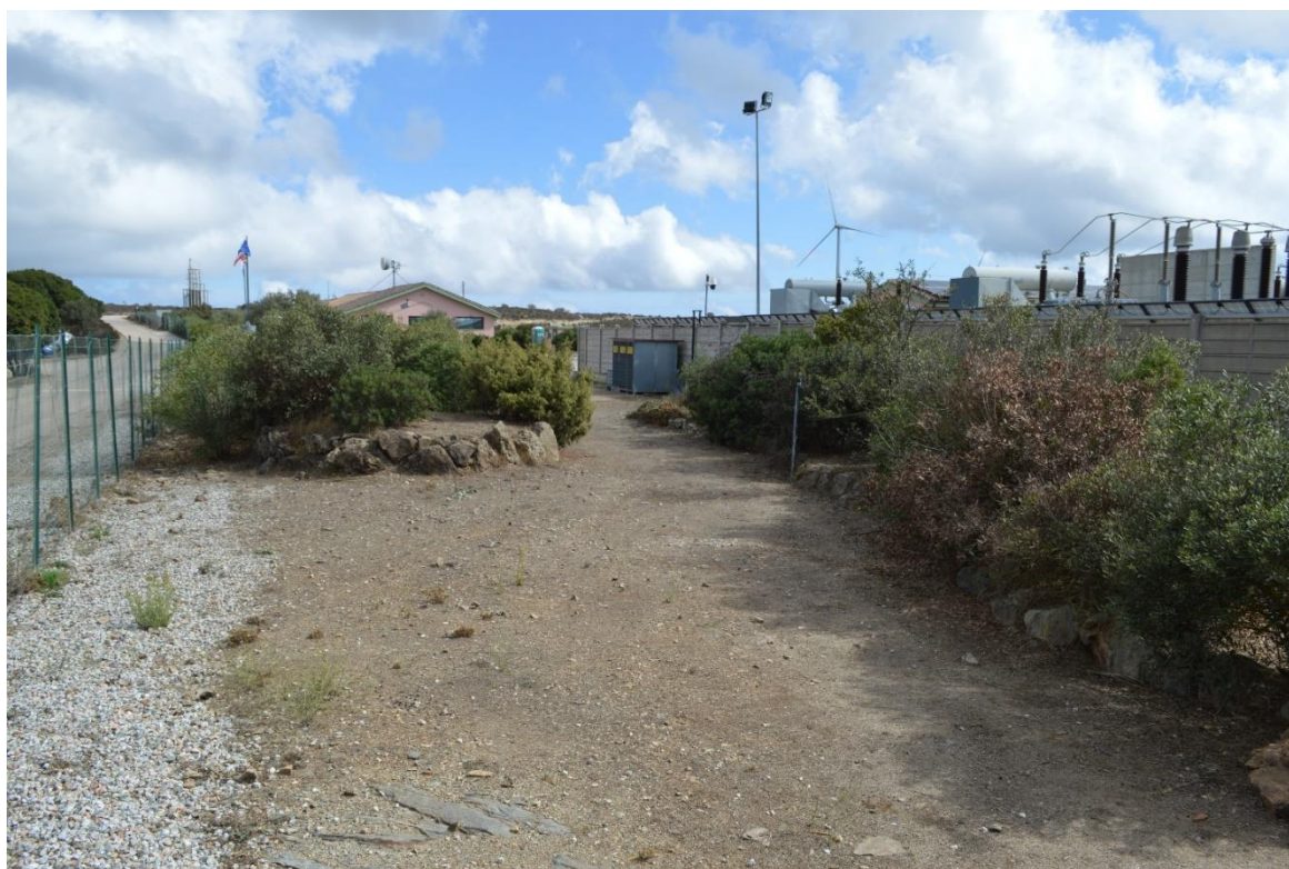
Figura 2 - Aiuole dell'area interna a nord della stazione elettrica. Vista W → E
