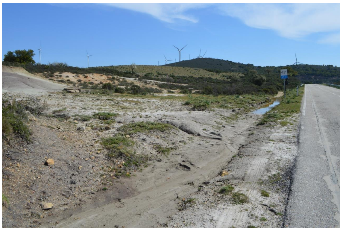
Figura 10 - Sito di intervento. Vista da S.P. 13, W → E
