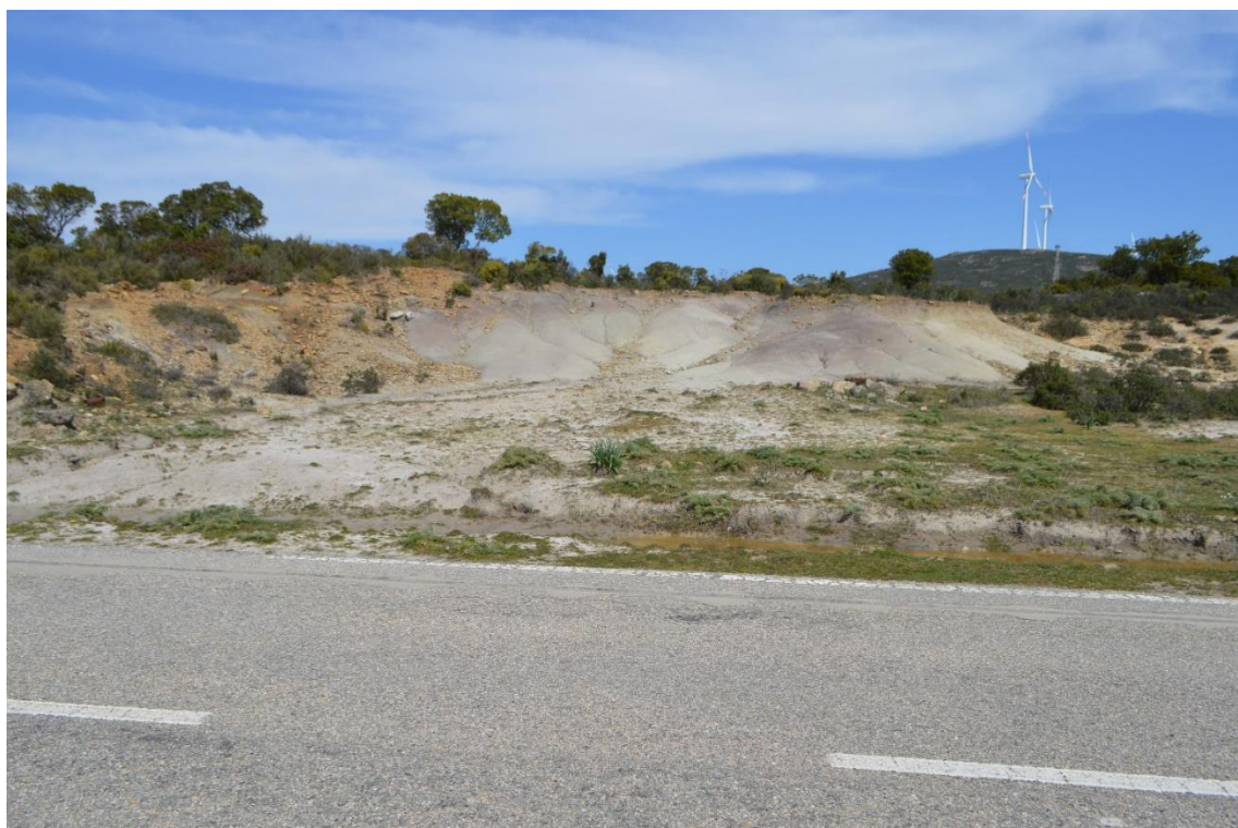
Figura 9 - Sito di intervento. Vista da S.P. 13, S → N
