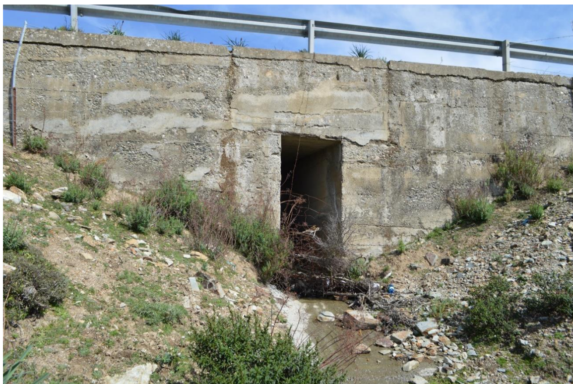
Figura 16 - Sottopasso per il deflusso delle acque meteoriche al di sotto della S.P.13, lato sud
