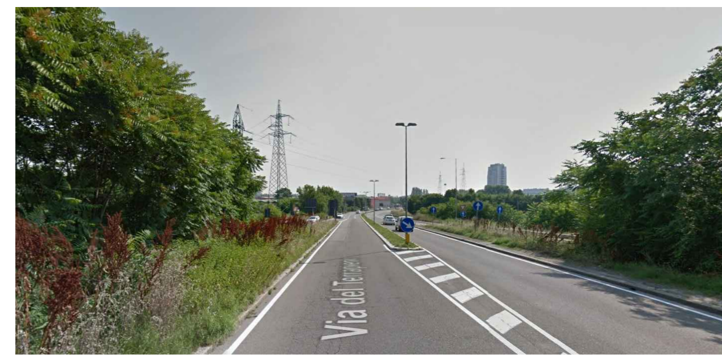
VIA DEL TERRAPIENO - FINE SOVRAPPASSO DIREZIONE EST
