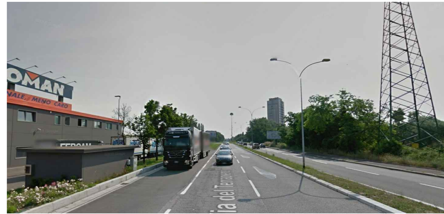
VIA DEL TERRAPIENO - BARACCA DA RIPOSIZIONARE
