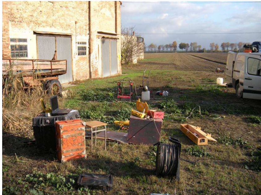
Figura 2.7 – Operazioni di acquisizione dati del carotaggio sismico CH eseguito sulla coppia di fori 1FEBH09 e 1FECH09 (località Bondeno).
