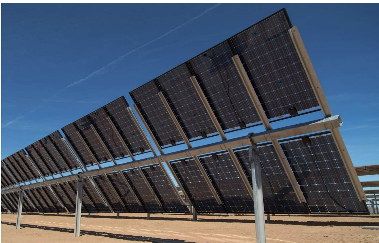
Figura 5: Esempio struttura + modulo FV bifacciale
