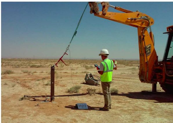
Esecuzione di pull out test
