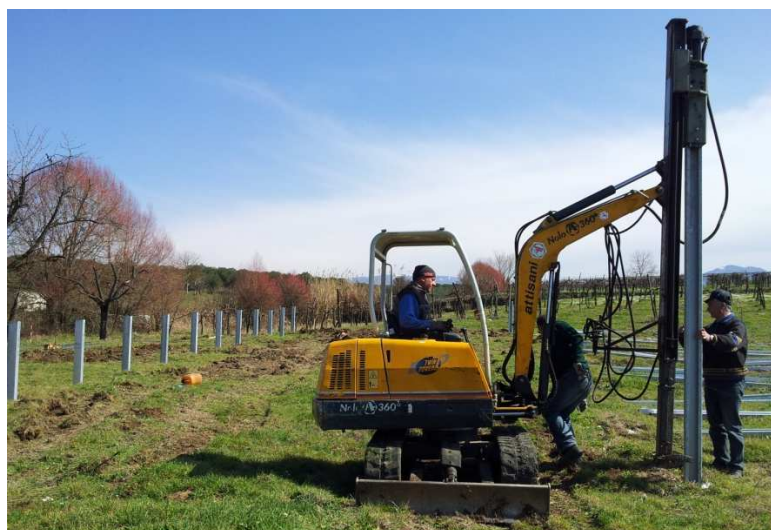
Figura 9 – Infissione per battitura
