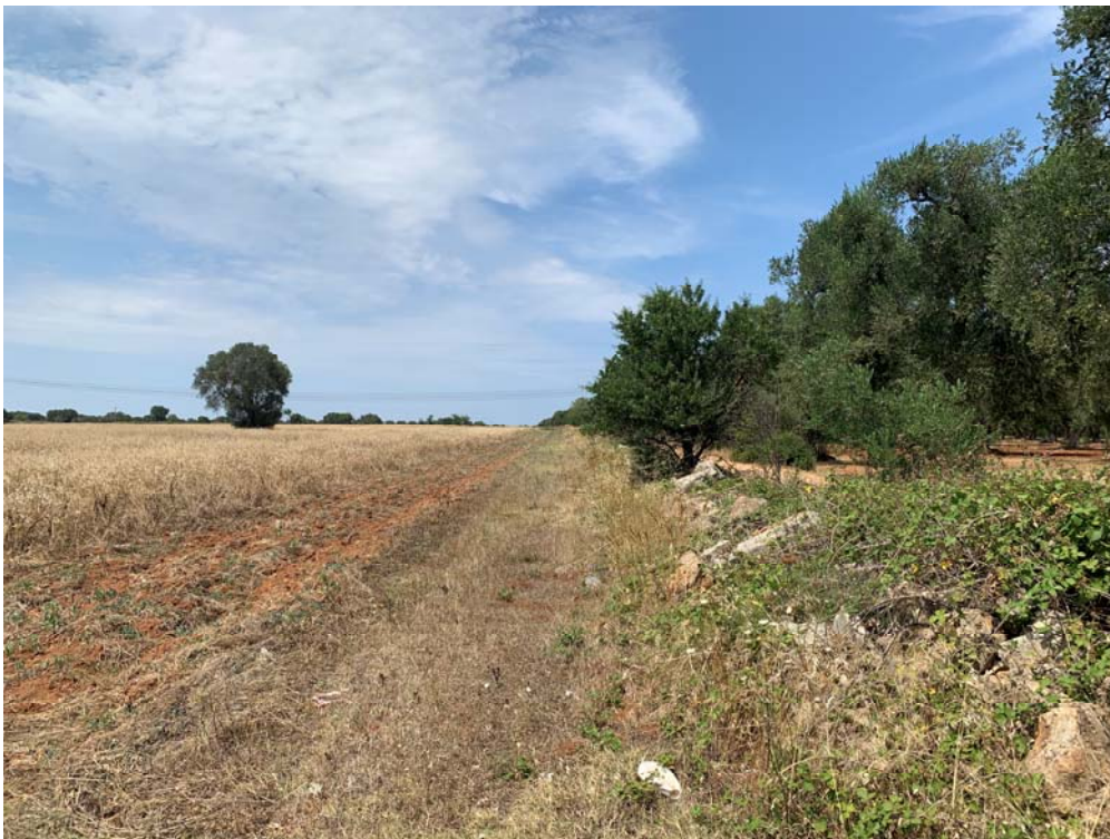
Foto muretto che costeggia la SC vista lato terreno agricolo Il muretto è ridotto ad un cumulo di pietre informi
