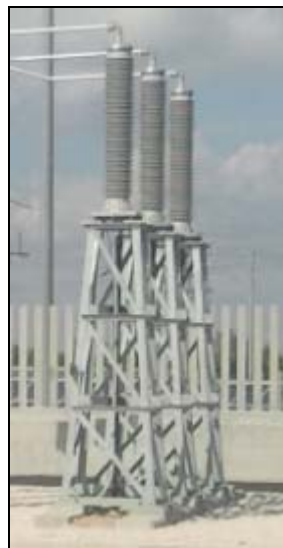
Fig. 26. Terminale cavo AT tipo.
