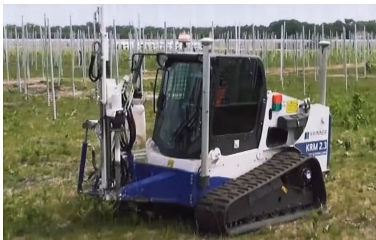
Fig. 4. Esempio di fissaggio delle strutture di supporto
