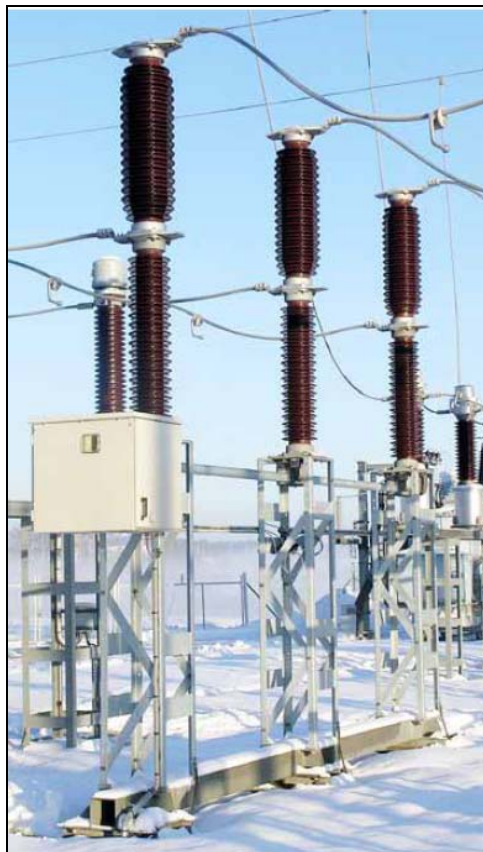
Fig. 34. Particolare Interruttore con TA incorporato.
