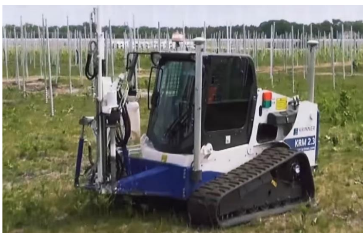
Fig.6. Esempio di fissaggio delle strutture di supporto
