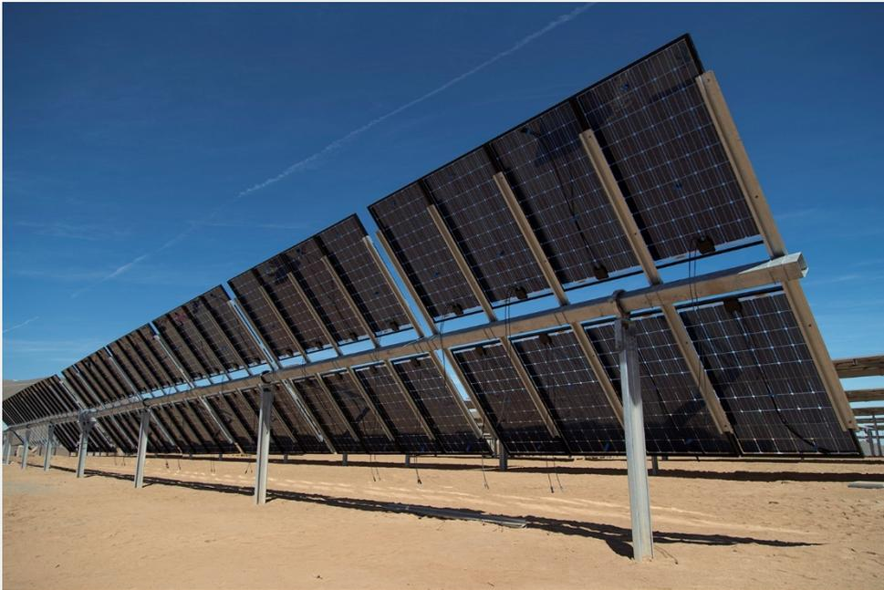
Figura 1 – vista prospettica inseguitore solare monoassiale
