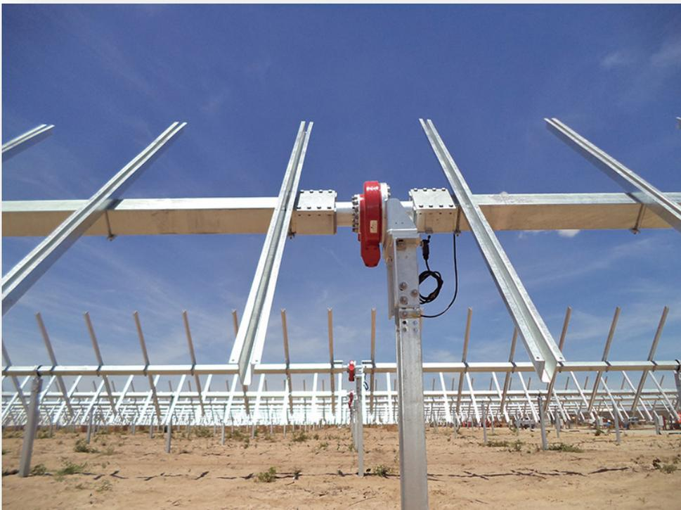
Figura 2 – Struttura dell'inseguitore solare monoassiale
