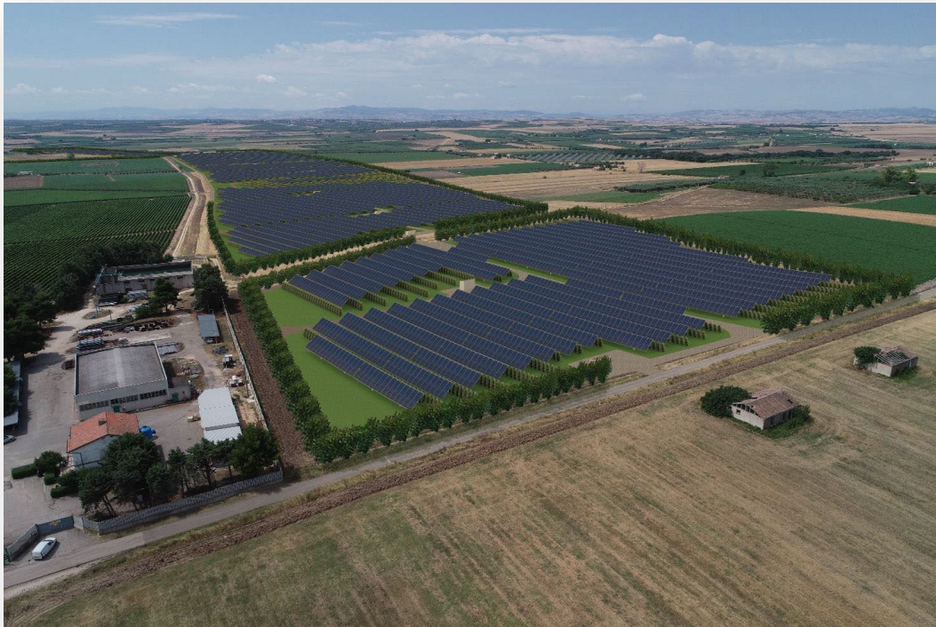
Figura 64 - Vista panoramica da nord
