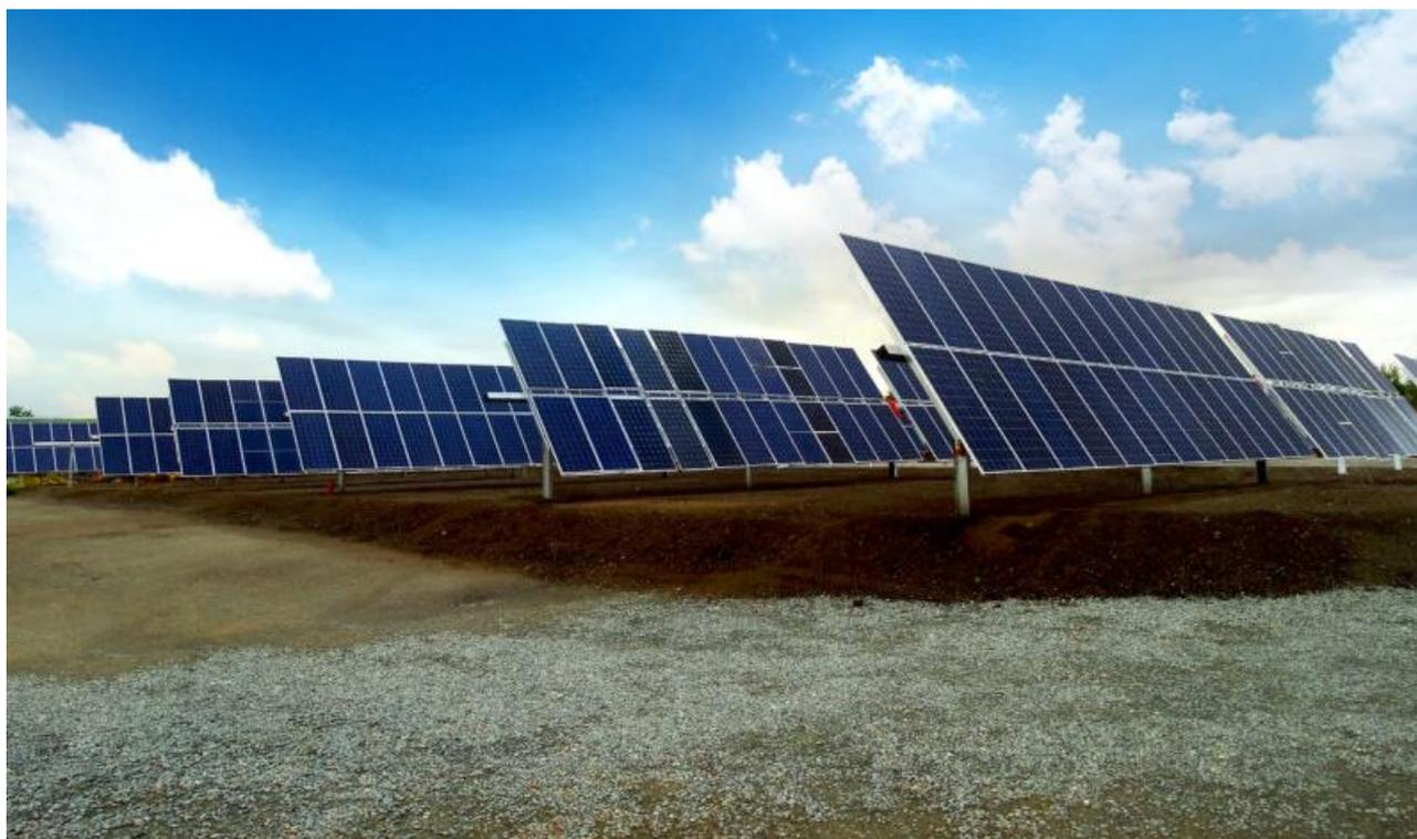
Figura 5 - immagine esemplificativa di inseguitori mono-assiali in configurazione 2P (fonte: Soltec)
