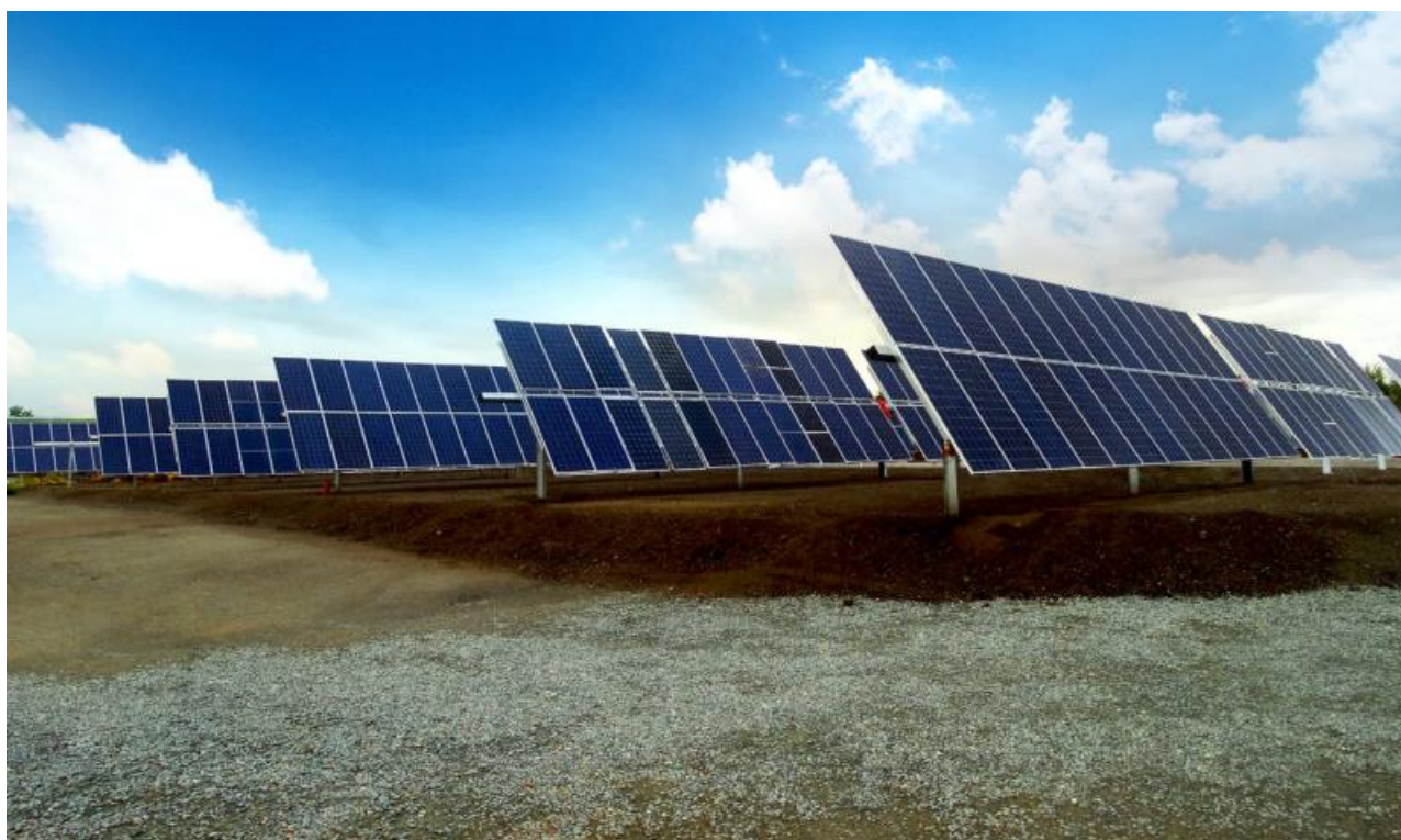
Figura 3 - immagine esemplificativa di inseguitori mono-assiali in configurazione 2P (fonte: Soltec)
