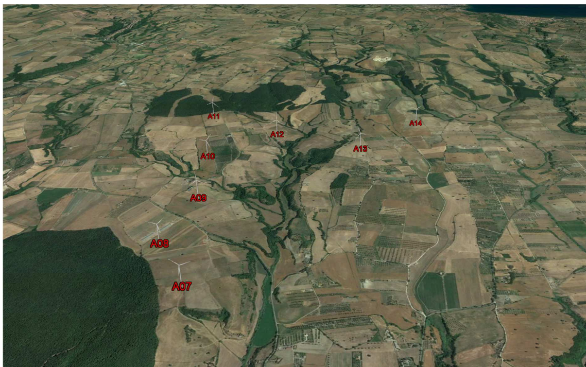
Figura 7: Individuazione degli aerogeneratori di progetto previsti nell'area B (etichette in rosso) su ortofoto 3D con vista da Sud verso Nord.
