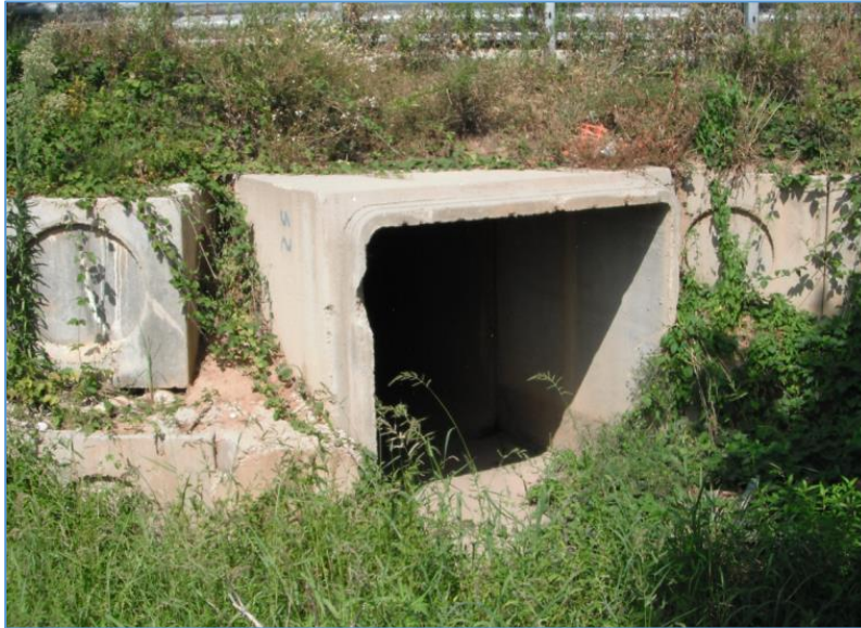
Figura 20 – Scatolare esistente sotto la rotatoria della tangenziale Sud, oggetto di prolungamento
