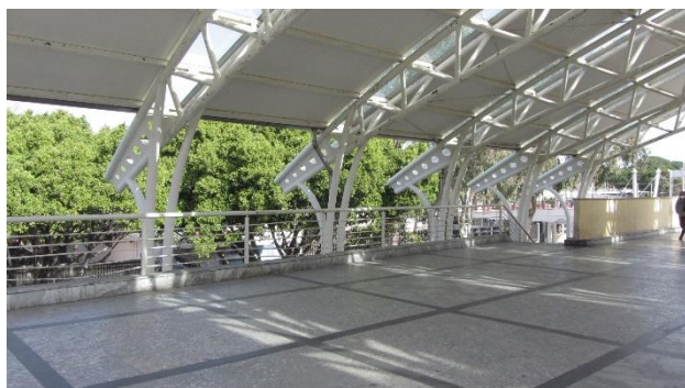
Figura 38 Corrimano esistente non a norma
