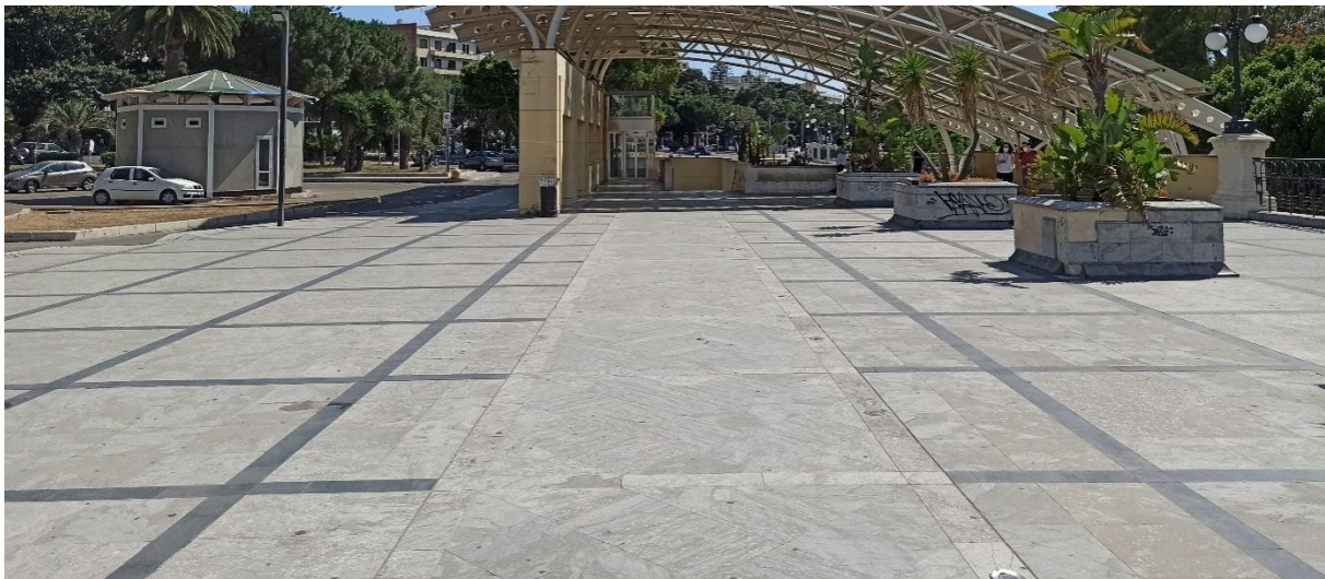
Figura 27 Particolare fotografico della pavimentazione
