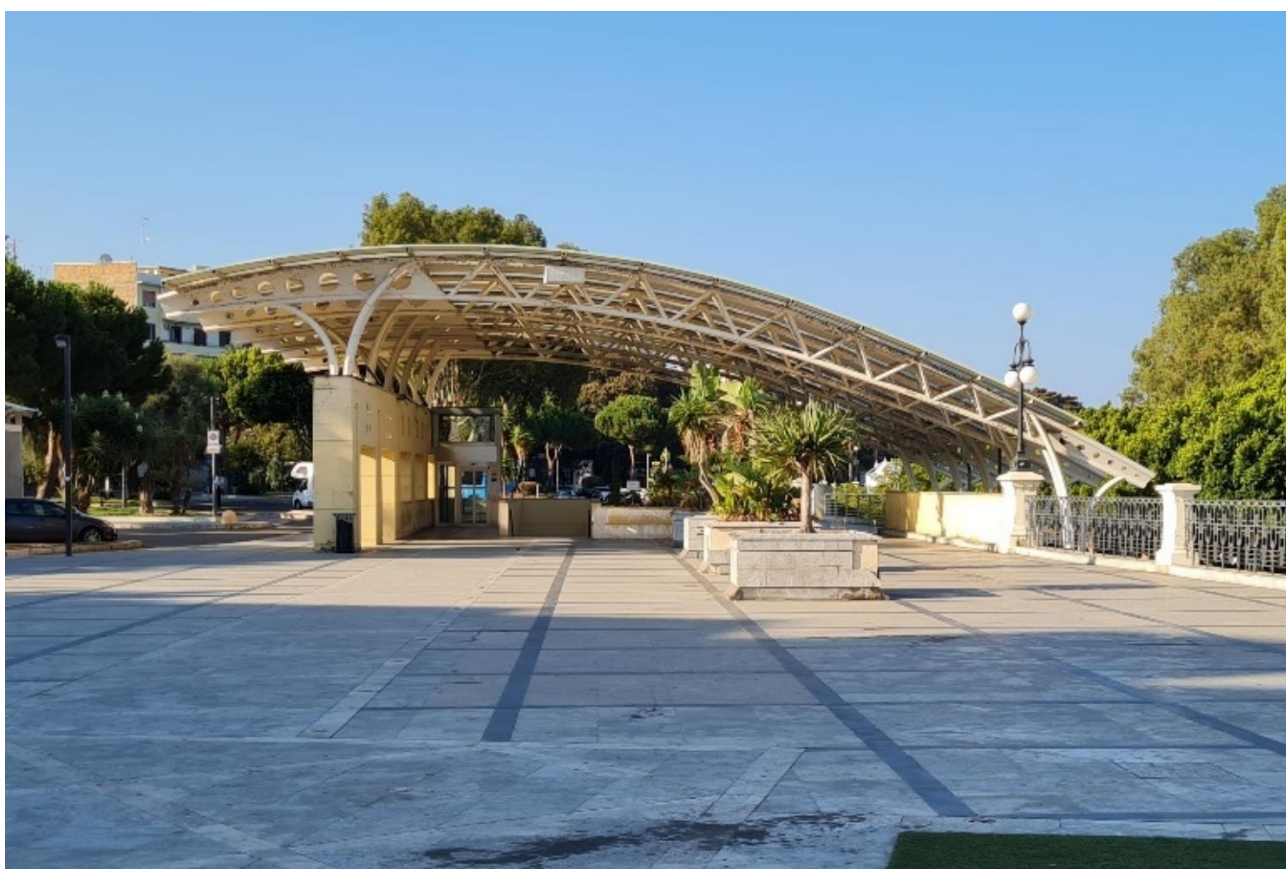
Figura 23 Foto laterale ingresso stazione
