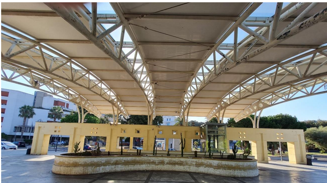
Figura 24 Foto porzione coperta della stazione
