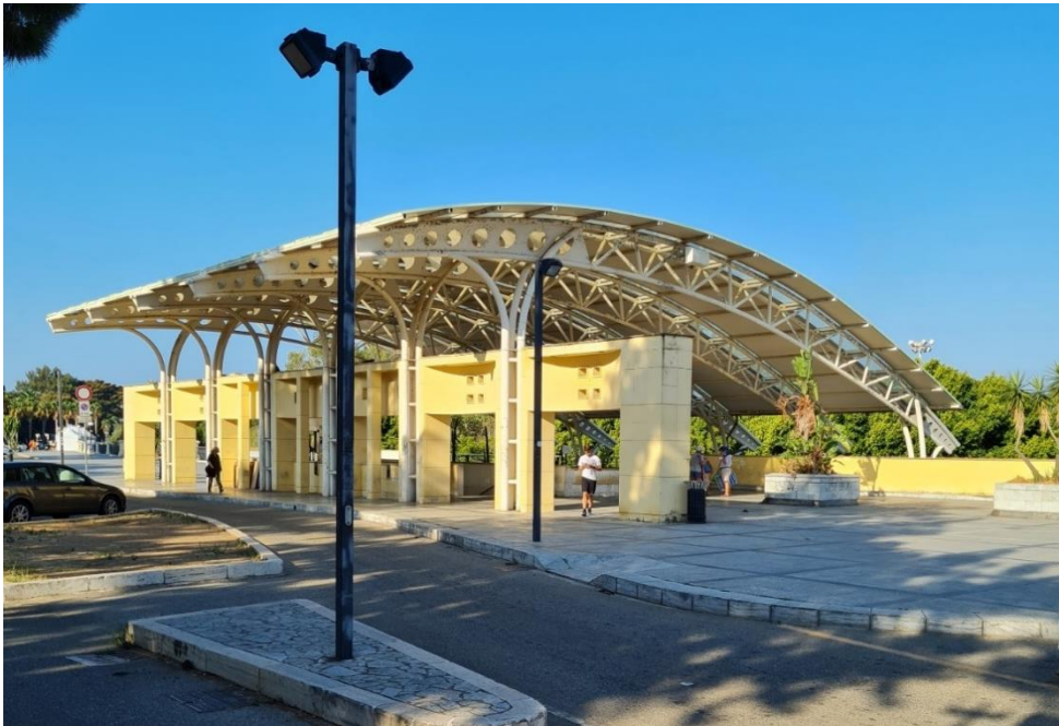
Figura 22 Copertura e setto murario della stazione
