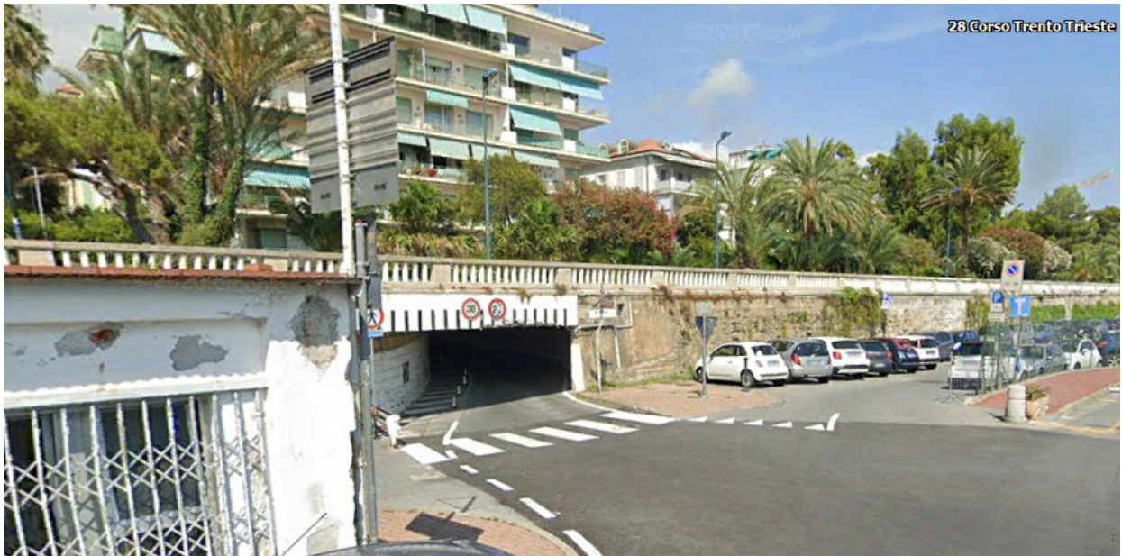
Fig. 04 – Da valle verso monte, l'uscita del sottopasso stradale di Via del Castillo
