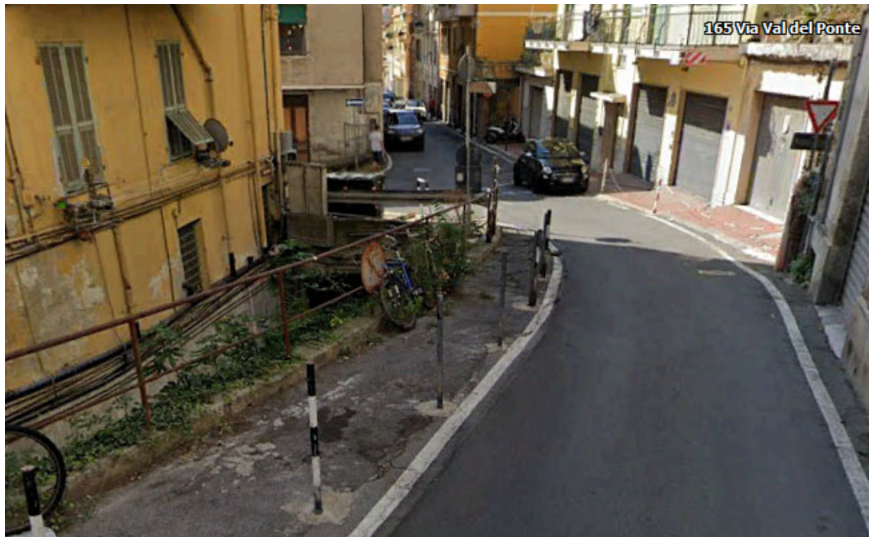
Fig. 02 – Da monte verso valle, vista della sezione di imbocco della tombinatura del Torrente San Lazzaro, posta in fregio a Via del Ponte. L'imbocco è posto in corrispondenza della sezione 16 del modello idraulico
