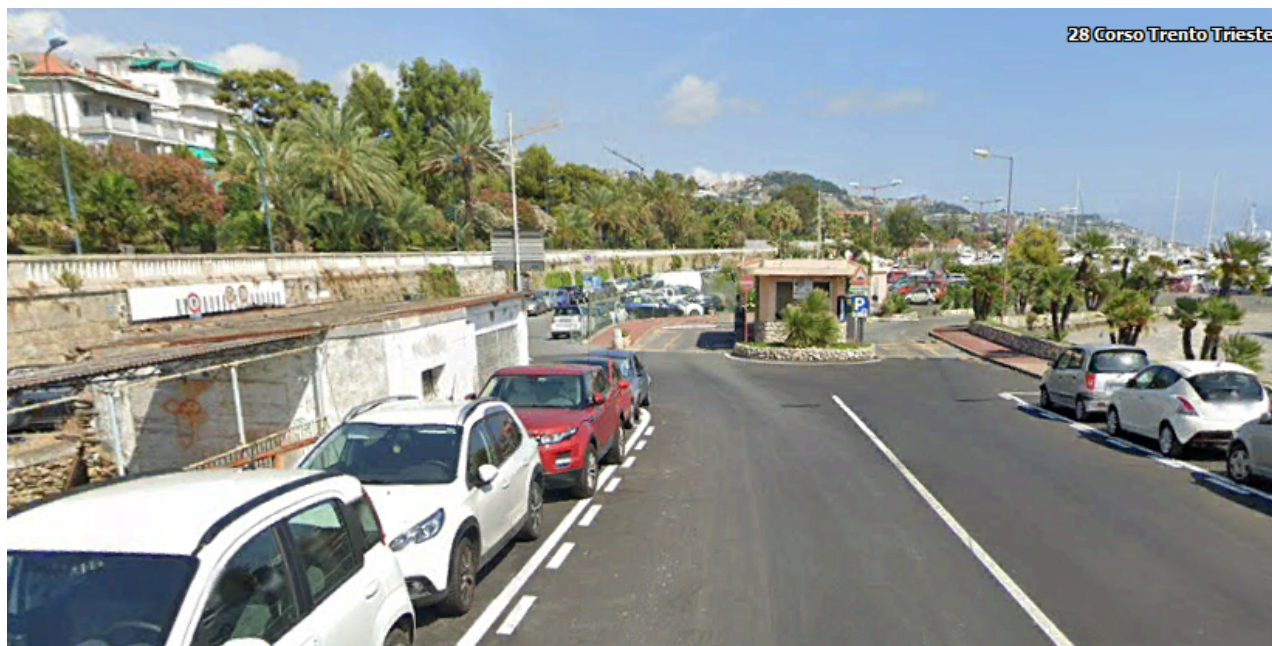
Fig. 09 – Vista da monte verso valle con banchina sulla destra della ripresa della zona di uscita dal sottopasso allagabile, area dove sorgerà la rotatoria di disimpegno stradale previa demolizione del manufatto esistente
