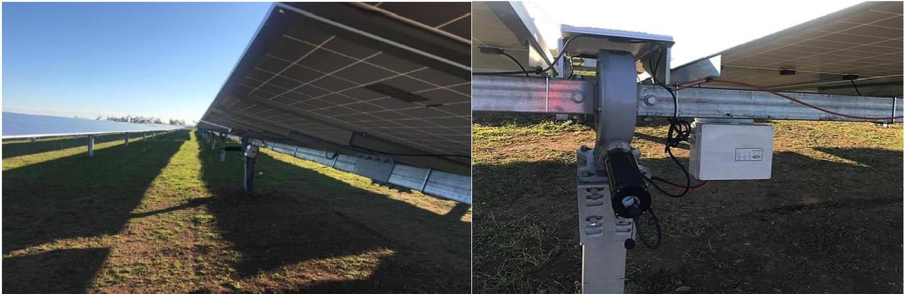
*Figura1–Struttura dell'inseguitore monoassiale tipo*
