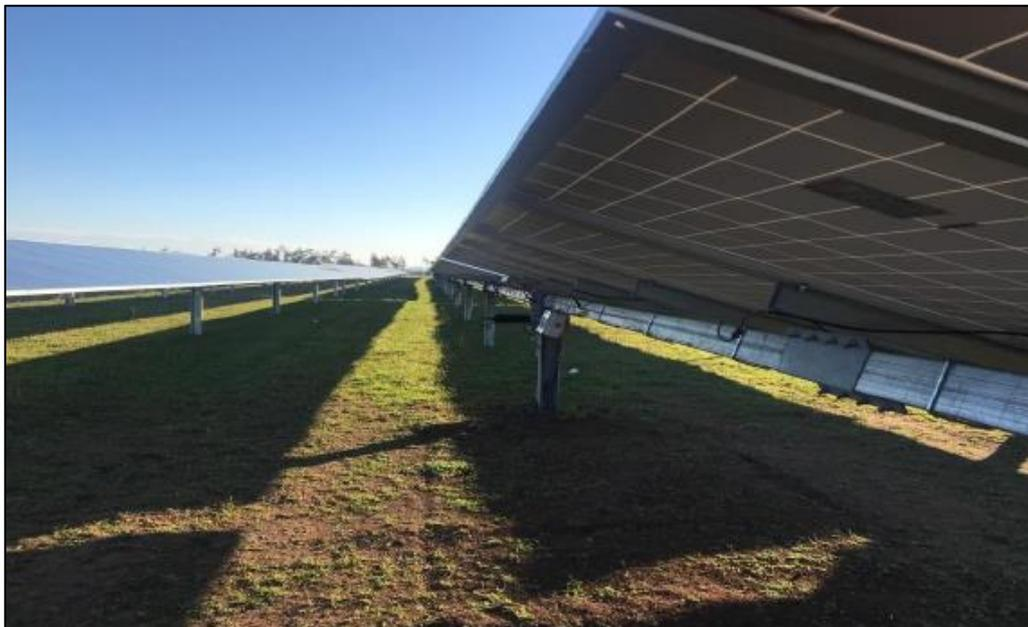
Figura 22 – esempio di struttura inseguitore monoassiale
