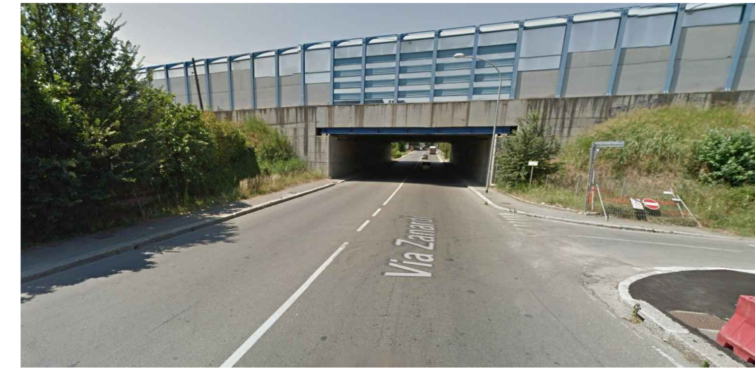
IMBOCCO SOTTOPASSO - DA SUD OVEST VERSO NORD
