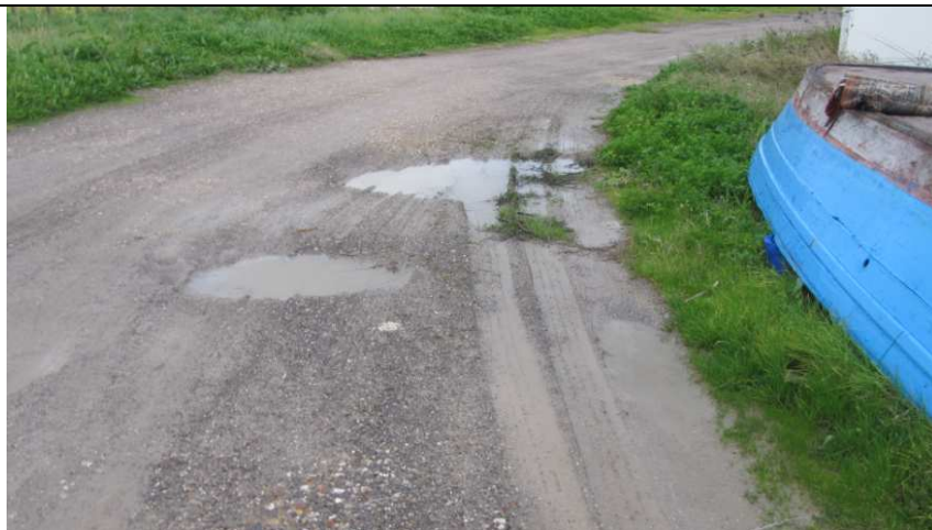
Alcune porzioni del piazzale di servizio in fase di degrado
