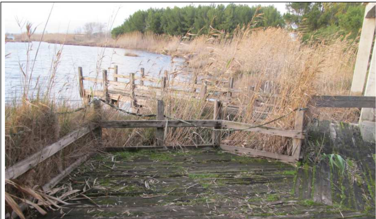
Passerella da ricostruire. Sulla destra si intravede lo sbocco dello scivolo coperto "sa domu de su motoscafu"
