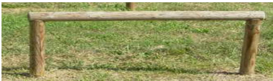
Tipologia realizzativa modulo cavalletto
