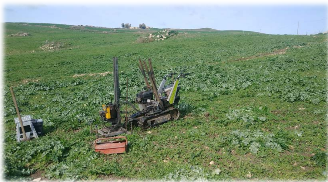
Fig. 4 – La foto, scattata durante l'esecuzione di una prova penetrometrica dpm_30, evidenzia la natura collinare del sito d' intervento
