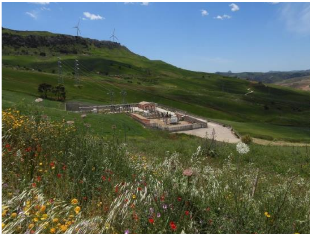
Stazione elettrica esistente di Marianopoli
