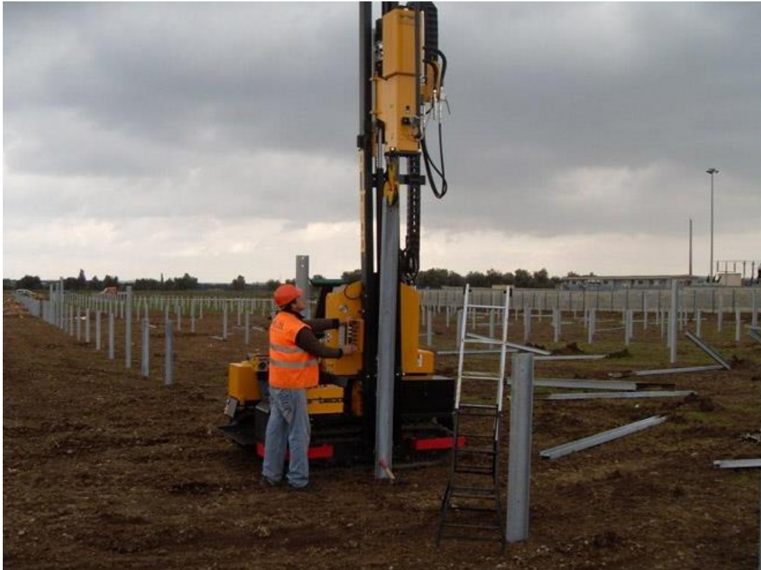
Fig.°19 Operazione di rimozione dei pali infissi
