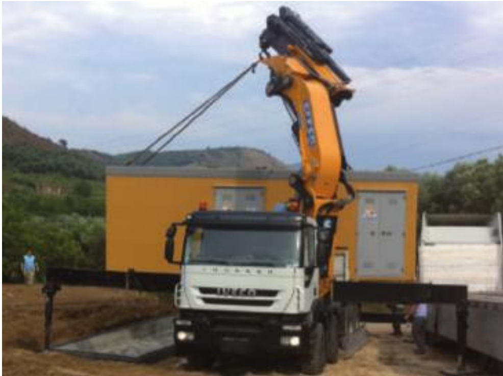
Fig. 20 Operazione di rimozione delle cabine prefabbricate
