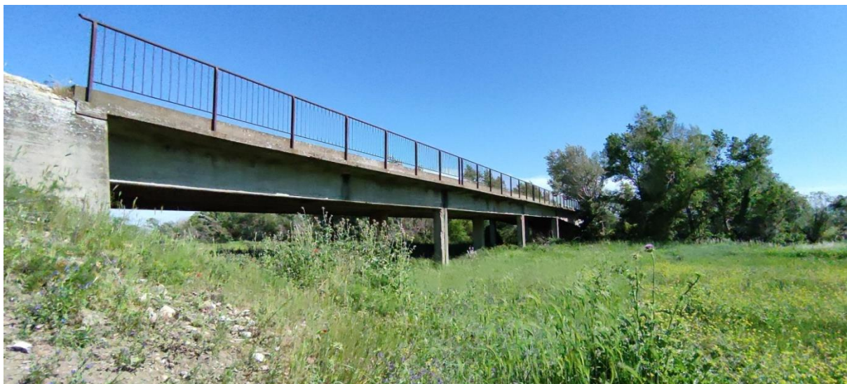
Figura 4-15: Ponte sul Fiume Ofanto (Cavidotto AT)
