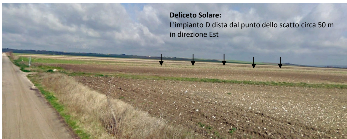
Figura 21 – foto da SP104 verso l'impianto D ed E
