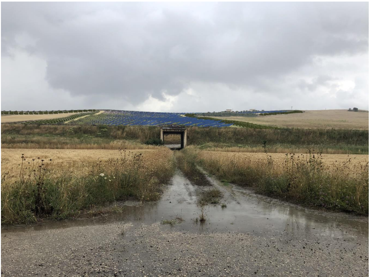
Foto n. 4/b -Situazione post-operam con mitigazione
