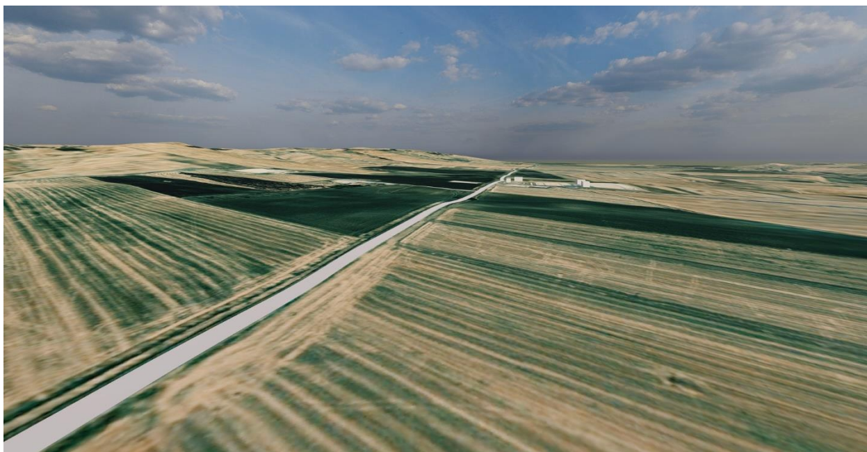
Figura 28.a – Situazione ante-operam – vista dall’alto
