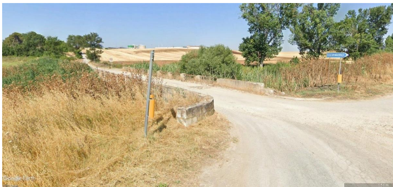
Figura 17 – foto attraversamento torrente
