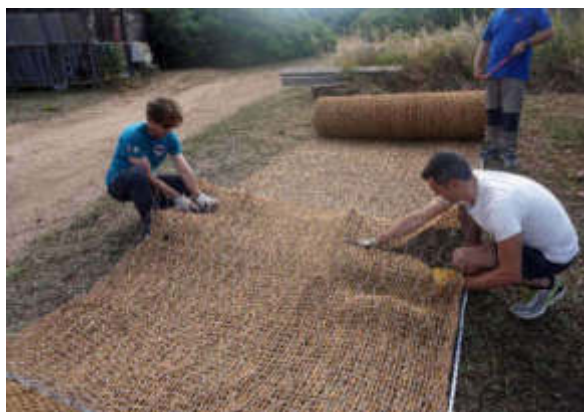
Fig. 69- Preparazione delle geostuoie prima della posa
