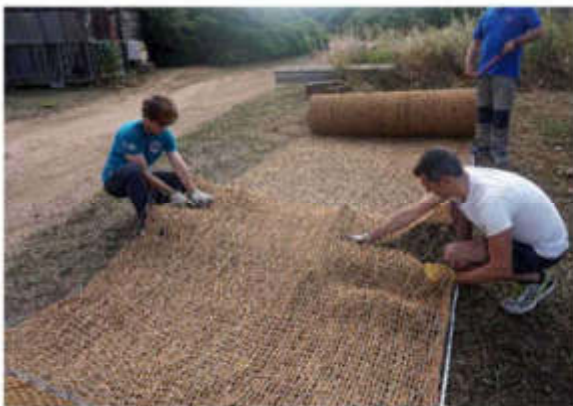
Preparazione delle geostuoie prima della posa Sant'Amanza (Corsica)
