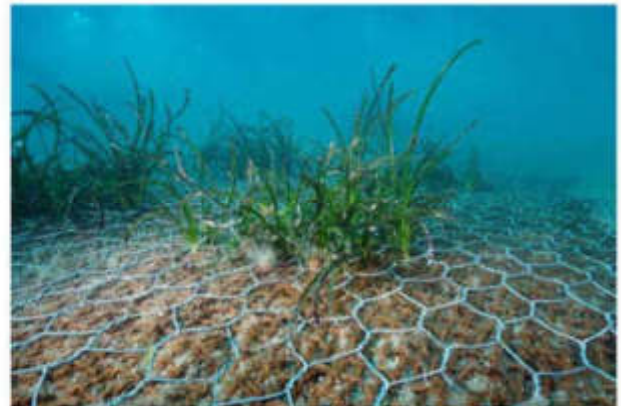
Geostuoie posizionate sul fondale Sant'Amanza (Corsica)
