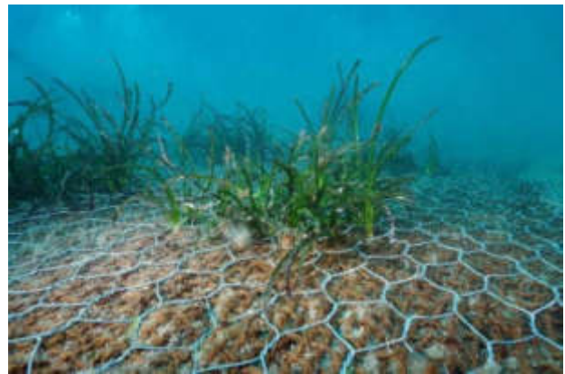
Fig. 68- Geostuoie posizionate sul fondale di Sant'Amanza
