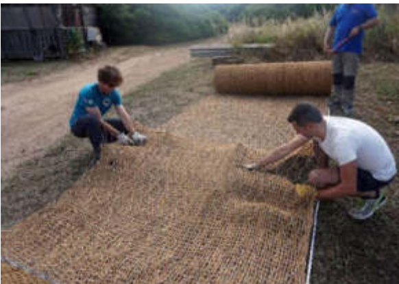
Fig. 67- Preparazione delle geostuoie prima della posa (Corsica).
