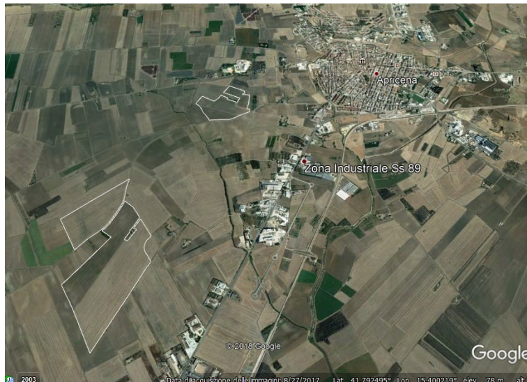
Figura 5 – Area Impianto fotovoltaico
