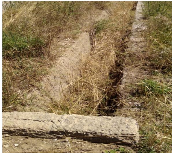
Figura 3-3 – Inerbimento fosso e attraversamento idraulico in corrispondenza di un accesso
