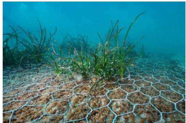
Fig. 68- Geostuoie posizionate sul fondale di Sant'Amanza
