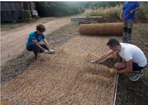
Fig. 67- Preparazione delle geostuoie prima della posa (Corsica).
