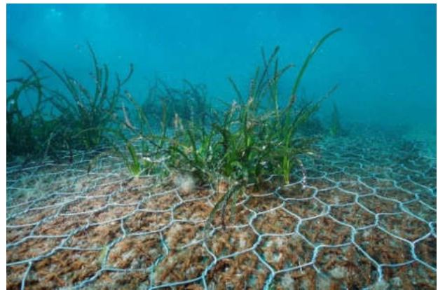
Fig. 68- Geostuoie posizionate sul fondale di Sant'Amanza
