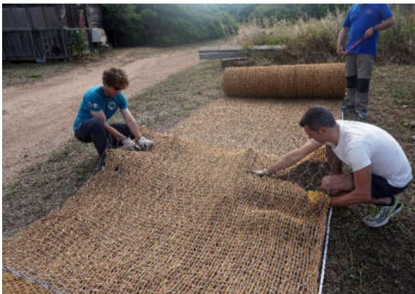
Fig. 67- Preparazione delle geostuoie prima della posa (Corsica).
