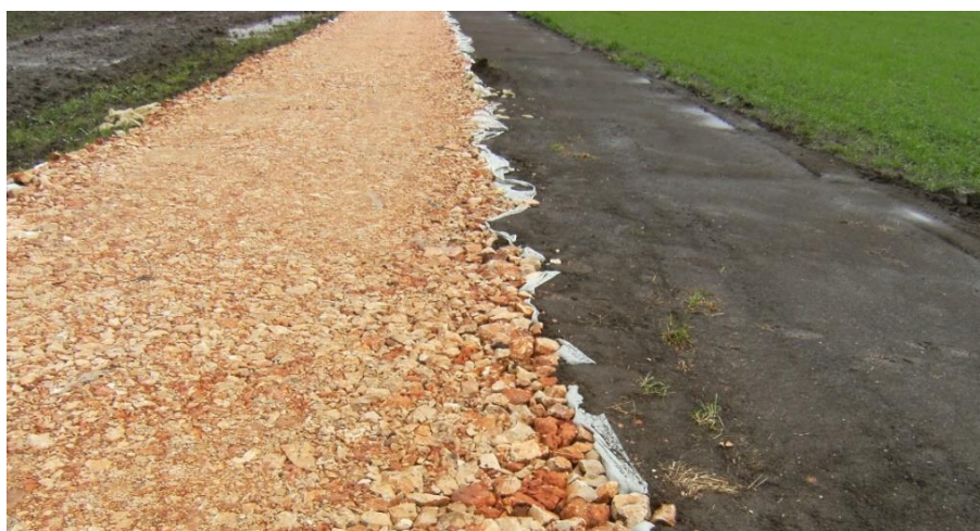
Esempio di strada interna al parco fotovoltaico
