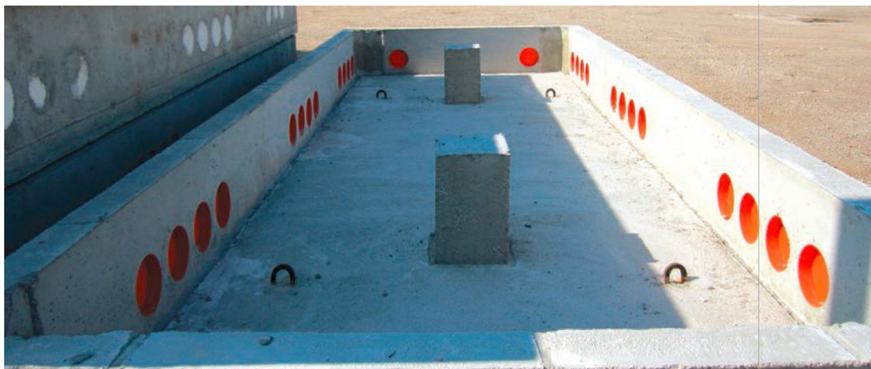
Figura 10 - Vasca di fondazione in CAV
