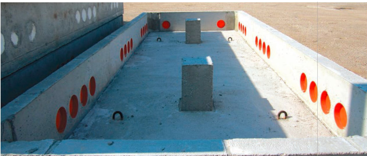
Figura 3 - Vasca di fondazione in CAV
