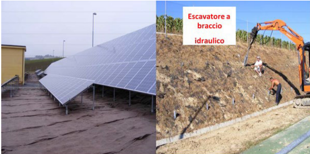
Figura 63 - Esempio di posa delle strutture portanti
