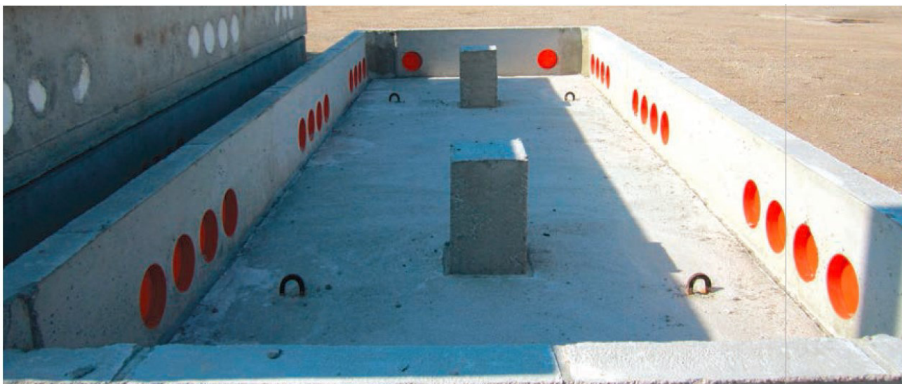
Figura 7 - Vasca di fondazione in CAV
