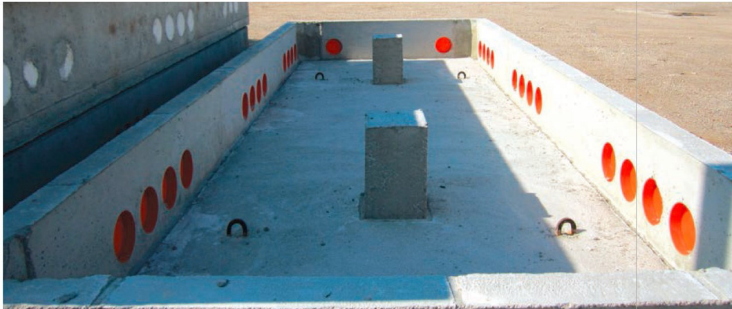
Figura 5 - Vasca di fondazione in CAV
