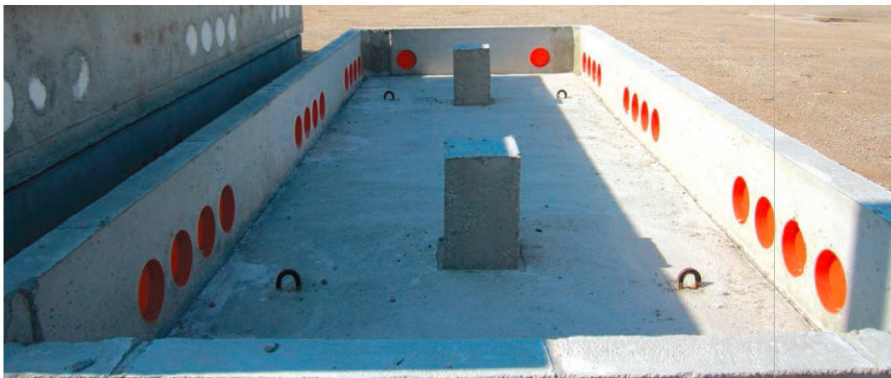
Figura 1 - Vasca di fondazione in CAV
