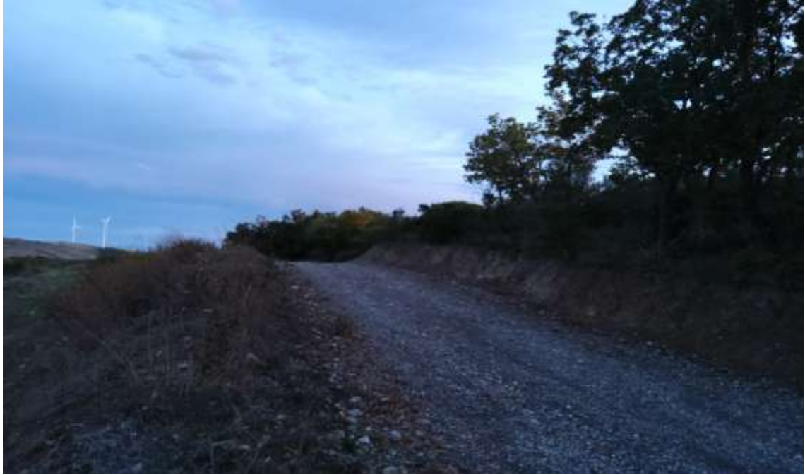
Foto 9 – Tratto della viabilità di servizio a monte dell'impianto
