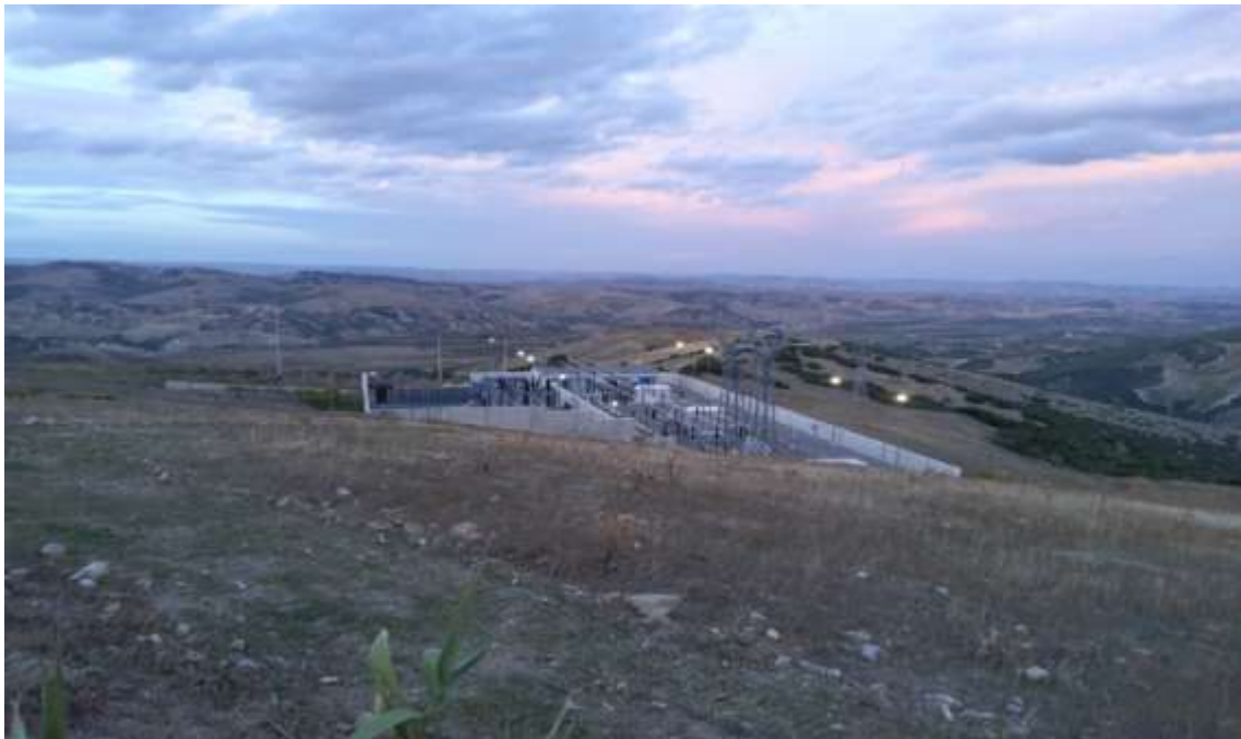
Foto 6 – Vista della Stazione elettrica Terna posta a monte dell'impianto
