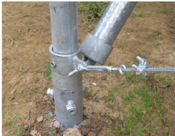
Figura 3. Infissione vite krinner e collegamento fra il montante del telaio verticale e la vite di fondazione
