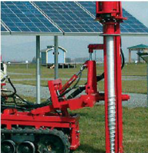
Figura 3. Infissione vite krinner e collegamento fra il montante del telaio verticale e la vite di fondazione
