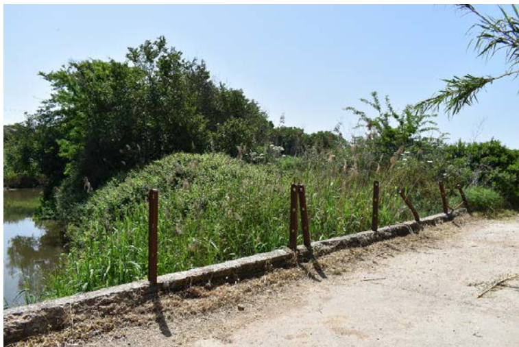
Il ponte su Riu Mannu – Foto 1
