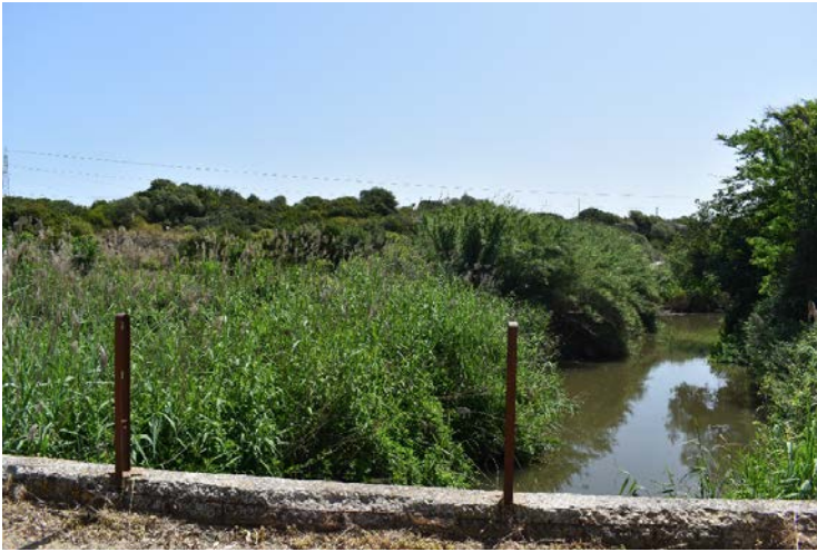
Ponte su Riu Mannu – Foto 2
