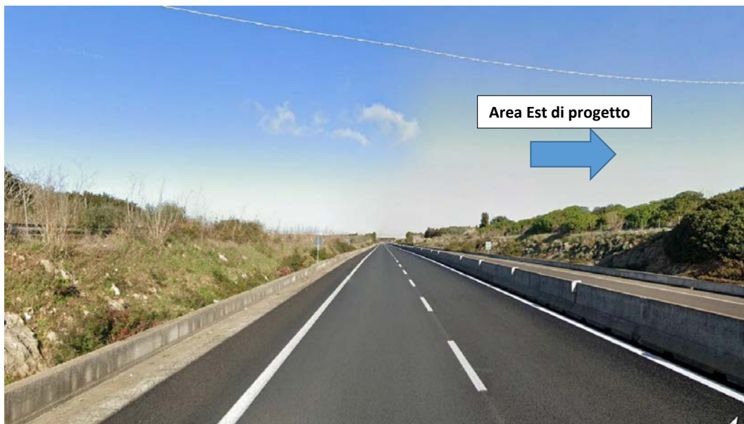
Un tratto della SS131 in prossimità dell'Area Est di progetto. E' evidente che la strada è realizzata in trincea e non è possibile avere un campo visivo libero percorrendola
