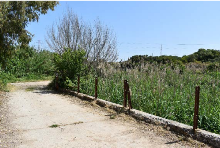
Ponte su Riu Mannu – Foto 3
